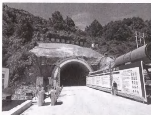
照片 10-1 北岭隧道一端
