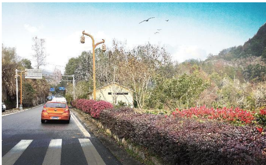
(2) 道路侧现有排水沟改造 改造前：
